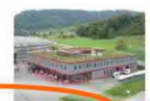
3073 WBSB Betriebsgebäude B
