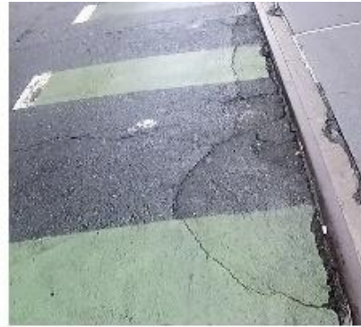
Edge Cracking
