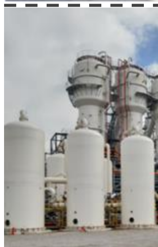
Steelanol : PSA 100.000 Nm 3 /h (320 kT CO 2 /a)
